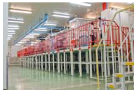
NOKタイにて1階設置設備を床上げ
